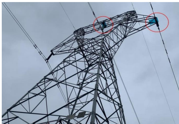
沙县区三金II路22号塔上安装的新型防鸟挡板(图上红圈处)。
