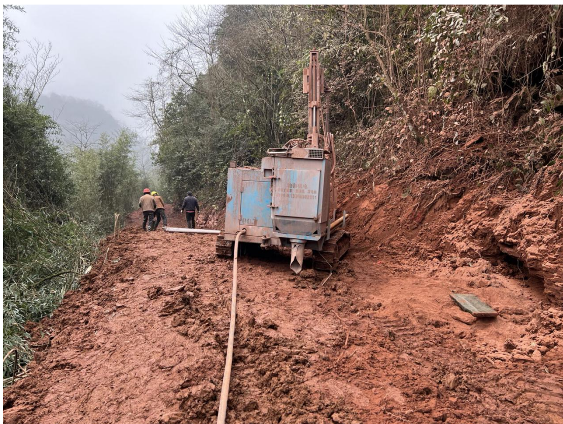
（三位工人正在操作灌浆，图片正中是一台灌浆机械。一位工人表示，他们要打三四十米深，用水泥浆把缝隙给堵住，大海子才能蓄水。 财新记者周泰来摄）
